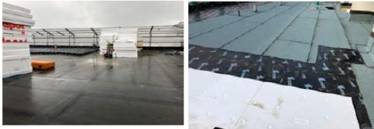
Flachdachdämmung
